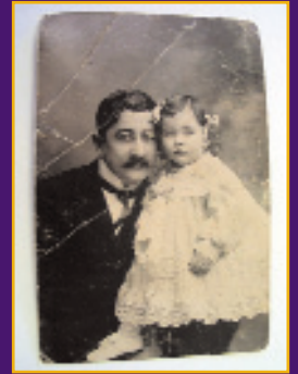
Prova colada em cartão. A intervenção foi feita apenas no suporte
