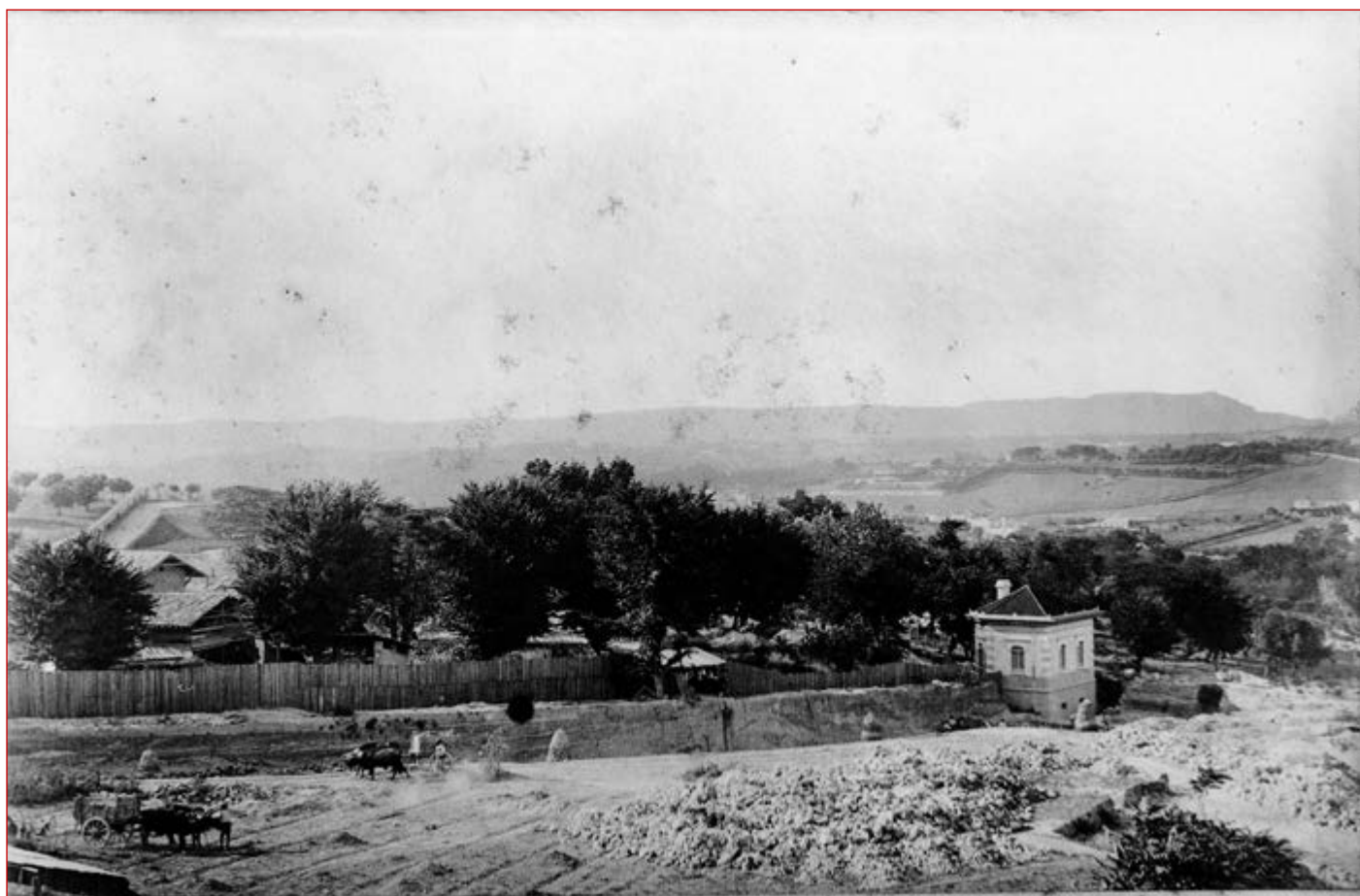
Figura 9 [Vista panorâmica da zona de São Sebastião da Pedreira no local de construção do Palacete Henrique de Mendonça], Eduardo Portugal, [1900-1902]. AML, PT/AMLSB/POR/060668.
