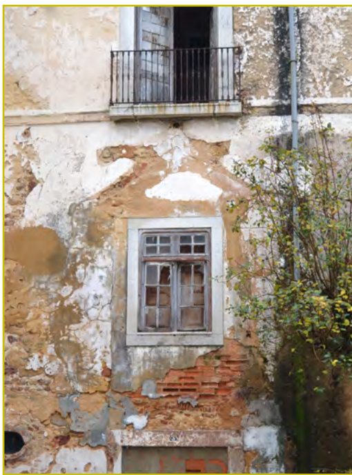
Figura 3 Pormenor das marcas decorrentes da justaposição do volume demolido que se observa na Figura 2, à esquerda, onde se nota a marcação no reboco das duas pendentes do telhado sobre a janela. Fotografia da autora.
